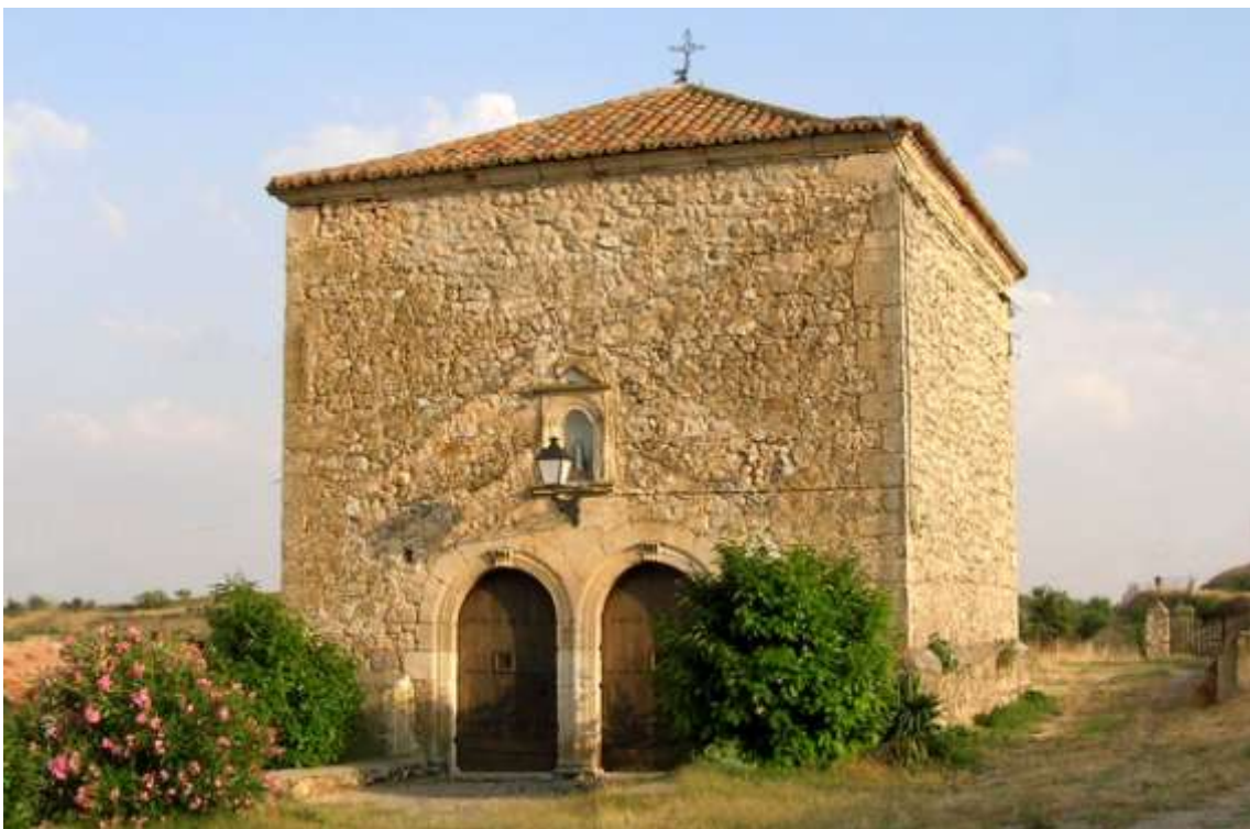
Ermita de la Soledad. Antes estaba cubierta su portada por un pórtico.
